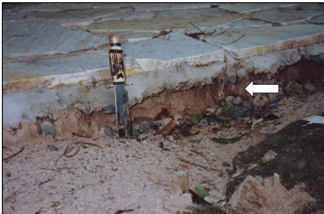
FIGURA 3.39 - RETIRADA DE FINOS NA BASE DA TRILHA, POR PERCOLAÇÃO HÍDRICA DIFUSA
