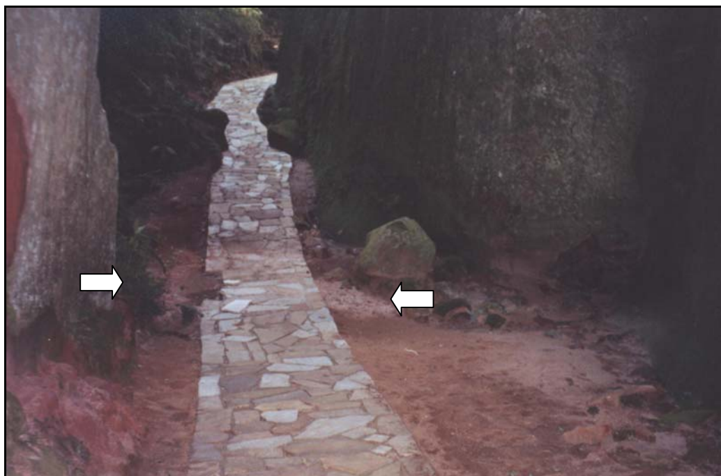
FIGURA 3.38 - ACÚMULO DE SEDIMENTOS EM TRILHA EM RELEVO CÔNCAVO
